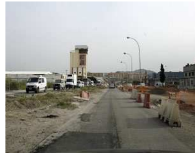
Trabajos de remodelación de la carretera Azucarera-Intelhorce. SALVADOR SALAS
