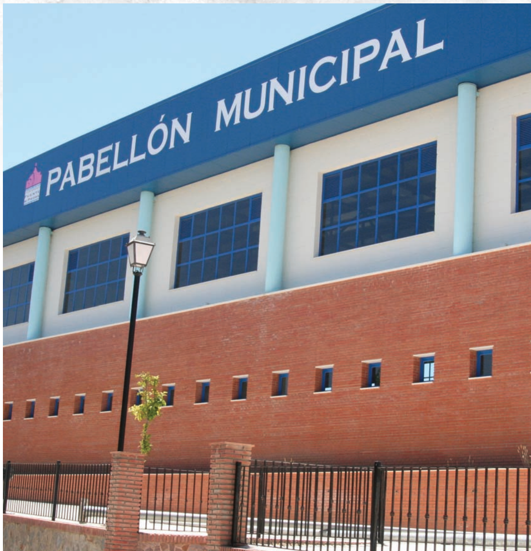
Pabellón Municipal de Fuente de Piedra.
